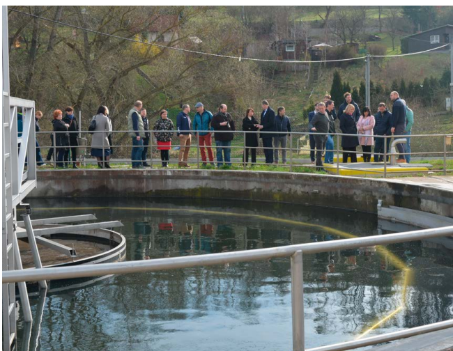
Součástí oslav boskovické divize byla odborná prohlídka nově zrekonstruované čistírny odpadních vod v Boskovicích
