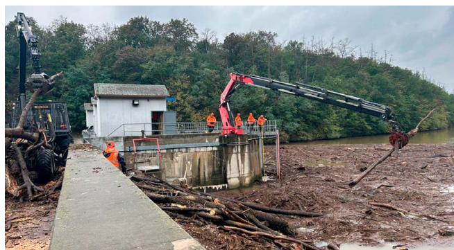
Odklizení naplaveného dříví na hrázi Znojemské přehrady
