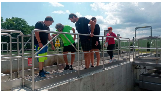
Zájemci si mohli prohlédnout čistírnu odpadních vod v Drnovicích
