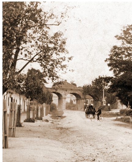
Městečko s původním viaduktem z roku 1838
