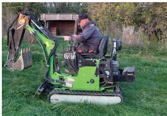
Technika pro výsadku stromů
