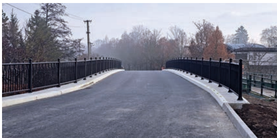
Pitrův most po rekonstrukci a v provozu
